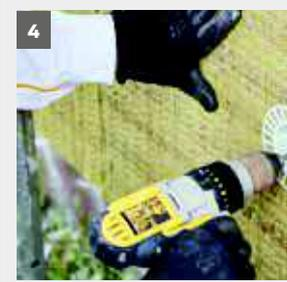
Die Platten müssen vor Feuchtigkeit geschützt gelagert werden. Durchnässte oder schadhafte Platten dürfen nicht eingebaut werden. Die Montage erfolgt mit **weber.therm Schraubdübel SRD-5** und Zusatzsteller **weber.therm VT 112 2G**. Hierbei werden die Dämmplatten ausschließlich horizontal verlegt. (800 mm Dimension in der Horizontalen). Nach Abschluss der Montage werden die in den
