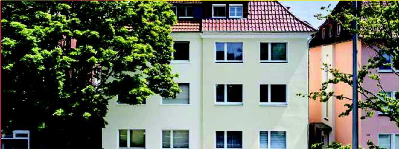
**WDVS rückbaubar-super-dickschichtig mit Mineralwoll-Platte und ausgesuchten mineralischen Oberputzen**
