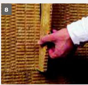
Bei nicht schlagregendichter Ausführung der Fensterbank ist eine zweite Dichtungsebene mit dem **weber.therm Sol-Pad** und **weber.tec Superflex D 2** vorzusehen. An allen Anschlüssen (z.B. Fenster, Türen, Dachrand und Übergang zur Sockeldämmung) ist ein vorkomprimiertes Fugendichtband zwischen Dämmplatte und flankierendem Bauteil einzulegen.
