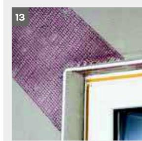
Alternativ können die Gewebeeckwinkel grob Kunststoff **weber.therm 313** mit Armierungsmörtel an den Ecken befestigt werden. Zur Sicherung gegen Ekrisse müssen dann Armierungspfeile **weber.therm 315** oder ein zurechtgeschnittenes Gewebestück (ca. 60 x 25 cm) in die Armierungsschicht eingebettet werden.
