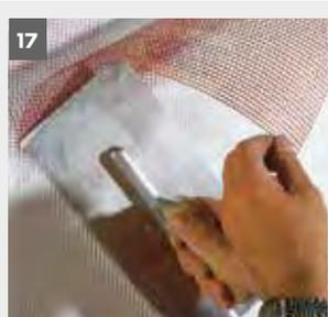
Anschließend wird das Armierungsgewebe fein weber.therm 311 in senkrechten oder waagerechten Bahnen mit Glätter oder Traufel faltenfrei in den Armierungsmörtel eingedrückt. Die Gewebekanten müssen an den Stößen mind. 10 cm überlappen (Abb. 17). Das Gewebe muss anschließend in der oberen Hälfte des Armierungsmörtels liegen.
