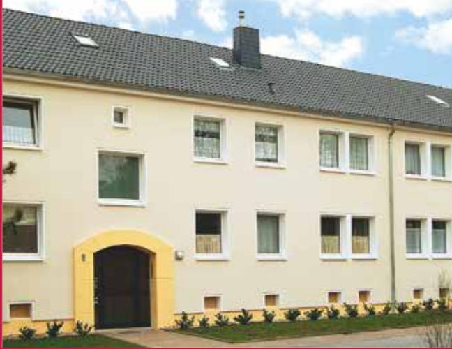
**WDVS mit EPS-Dämmplatte und dünnlagigem Putzaufbau**
