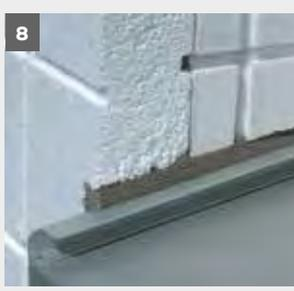
Bei nicht schlagregendichter Ausführung der Fensterbank ist eine zweite Dichtungsebene mit dem **weber.therm Sol-Pad** und **weber.tec Superflex D 2** vorzusehen.
