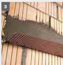
Von vorne kommt wiederum ein Panzereckwinkel auf die Dämmplatten, so dass die unteren Platten U-förmig von Panzereckwinkeln umfasst werden.
